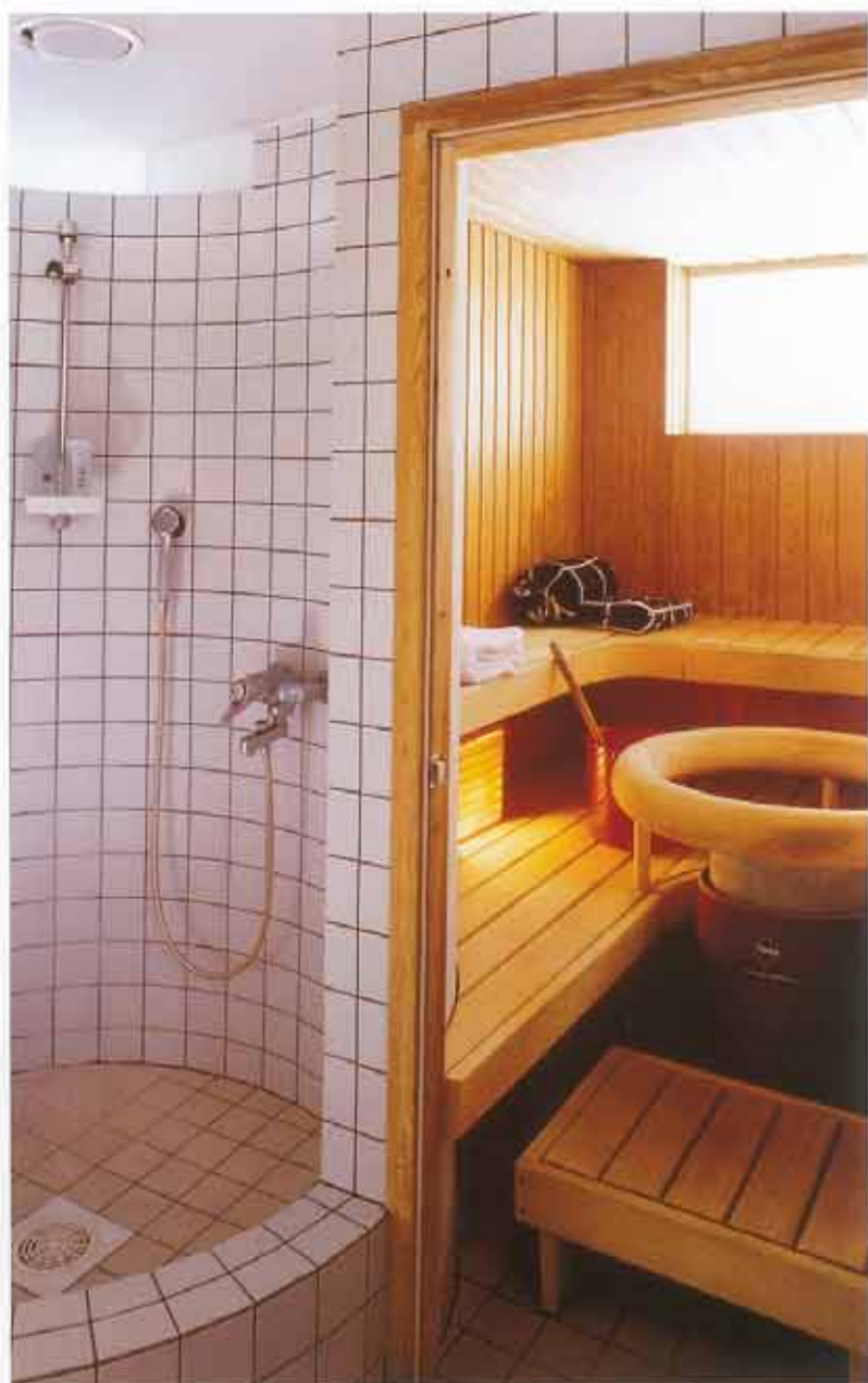
Ce n'est pas dans le dessin de son sauna qu'Eero Aarnio a le plus innové : carrelage en céramique blanc pour la douche, lambris de pin naturel dans le sauna.
